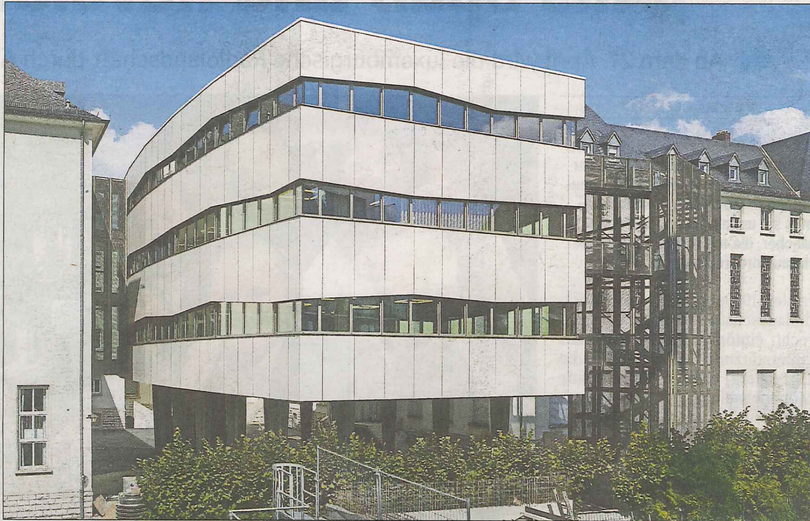
Das neue Gebäude aus Holz besticht vor allem durch seinen futuristischen Stil. (FOTO: COPYRIGHT LUKAS ROTH, KÖLN)
